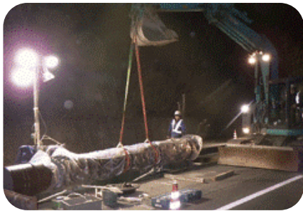
▲水道管の敷設工事
