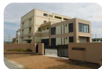
▲下郷雨水排水ポンプ場
