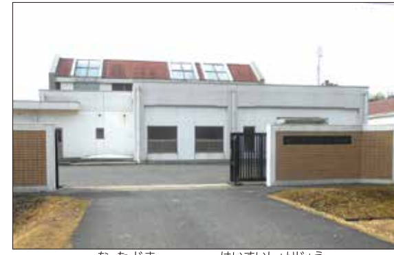
名田島地区の排水処理場
