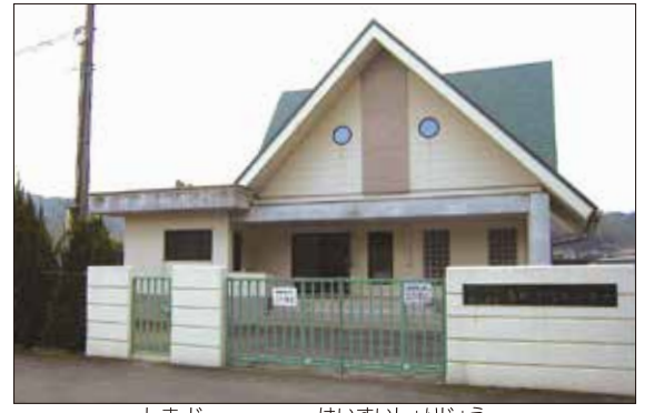
島地区の排水処理場
