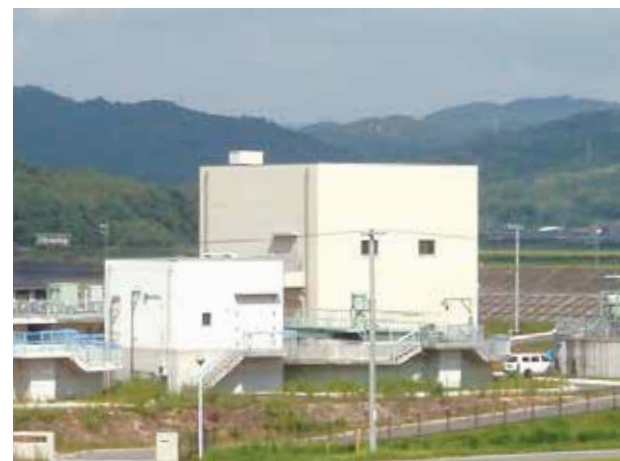
下水処理場 (川西浄化センター)
