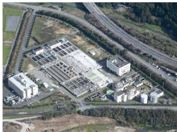
下水処理場 (山口浄化センター)
