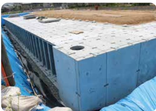
▼雨水貯留施設
