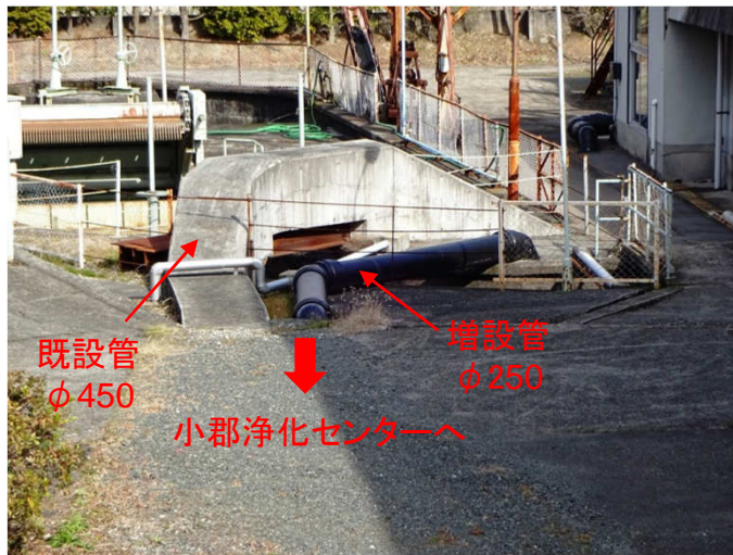
長谷ポンプ場圧送管
