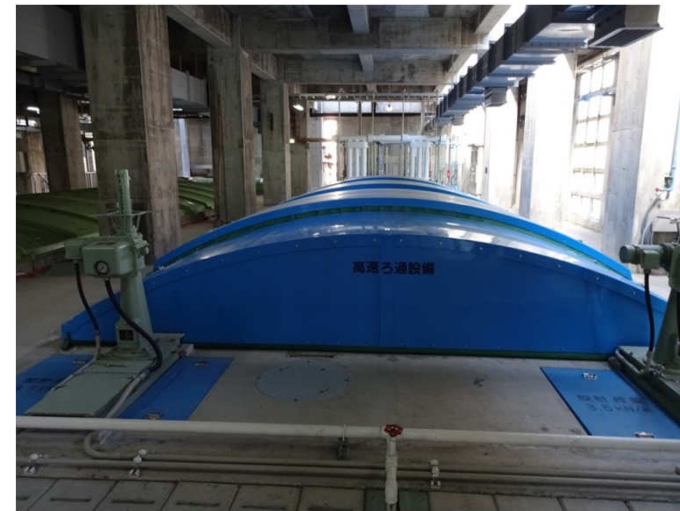
高速ろ過施設
