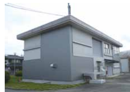
耐震工事が完了した小原水源地(平川)の電気管理棟
