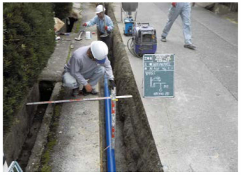
水道管の更新工事の様子
