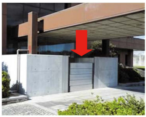
朝田浄水場の防水壁
