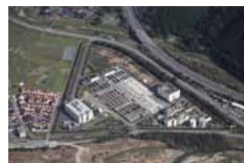
下水処理場(山口浄化センター)
