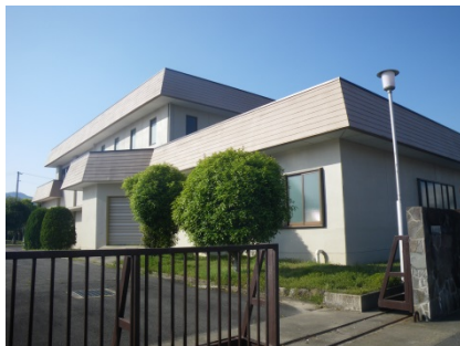
湯田中継ポンプ場
