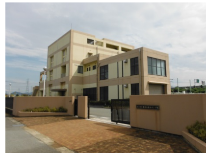
下郷雨水排水ポンプ場
