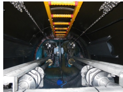
マンホール内部
