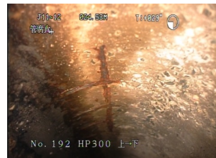
腐食による鉄筋の露出
