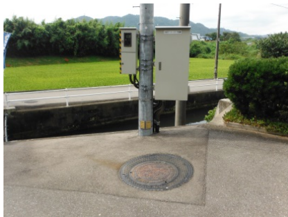
マンホールポンプ外観
